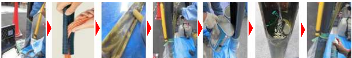
（点検・計測）（電気線配管取付）（接着剤の含浸）（繊維シート挿入）（充填状況）（充填済み）（錆止仕上げ塗装） ①事前調査 ②準備工 ③繊維シート設置 ④モルタル充填 ⑤外周補修処理
